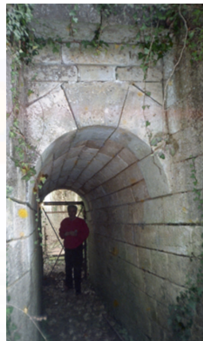
Gui Guirado w tunelu pod nasypem nieczynnej kolejki, przejście nad Charente
